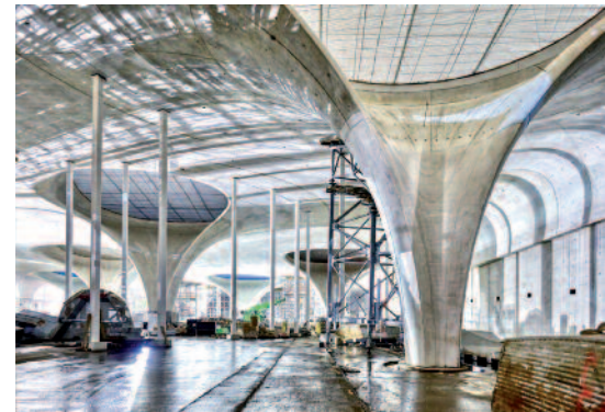
28 innovative Kelchstützen für den neuen Hauptbahnhof Stuttgart sind fertiggestellt
